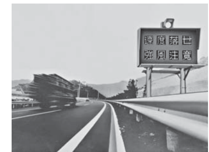
东名高速公路上所设置的世界首个道路气象信息系统（自动发出警报的电光显示屏）（1969年）
