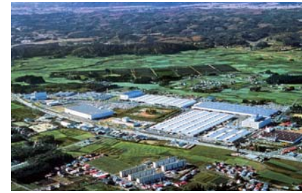
栃木事业所 (栃木县矢板市)
